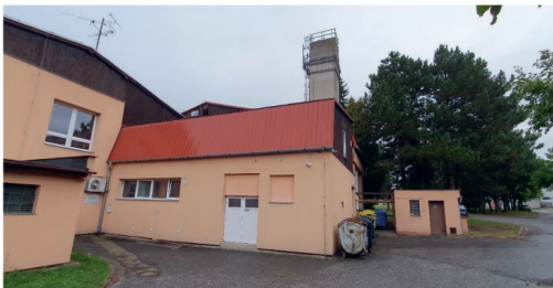
úpravna vody v budově ZŠ
